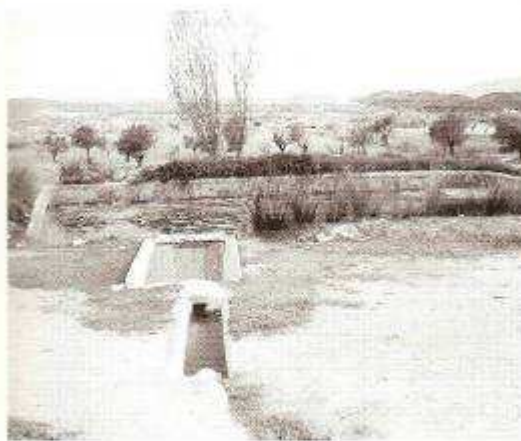
Acueducto, lavadero y balsa a la desembocadura del qanat cercano a la almazara.
