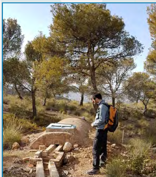
Aljibe de agua de lluvia que da suministro a un abrevadero y a varios aguaderos (depresión de Guadix, Granada)
