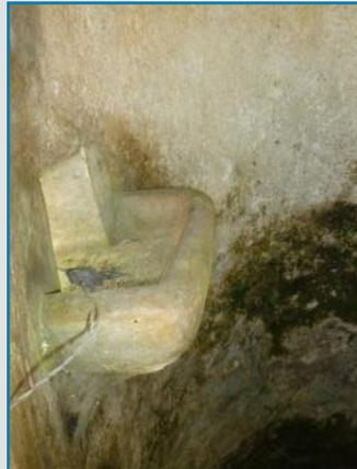
Detalle del interior de un pozo, donde se observa la pileta lateral a través de la cual se llenaban, a base de cubos de agua elevados con la carrucha, el abrevadero o lavadero exterior adosado al pozo.
