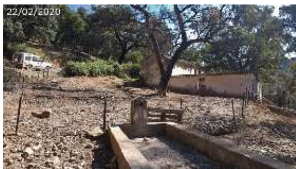
Abrevadero de la granja porcina con ésta al fondo (A. Ventas, febrero 2020)
