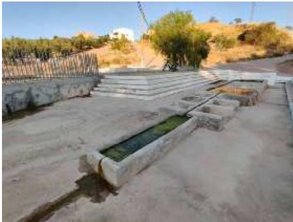
Pilar de Torrequebradilla (D. Sánchez Garrido, octubre 2020)
