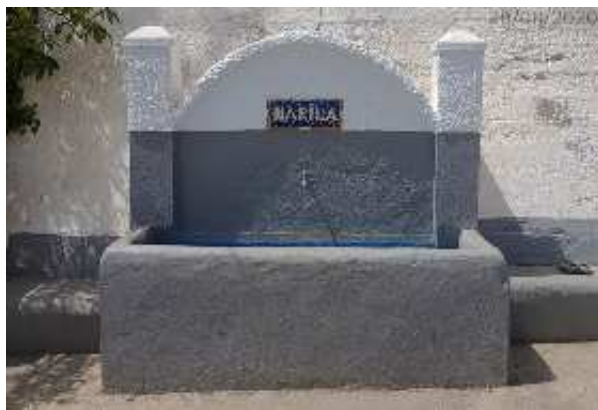
Fuente del Depósito, de frente (A. Ventas, agosto 2020)
