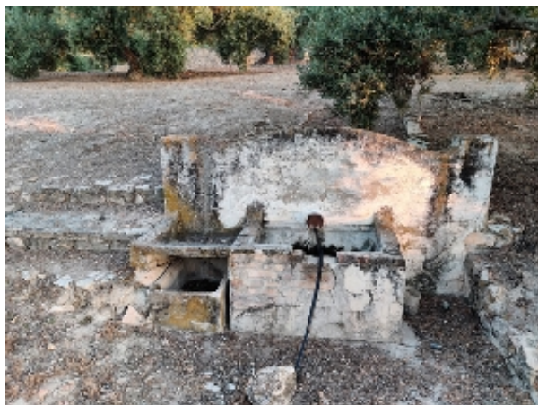
Vista general de la Fuente de Villa Julia (D. Sánchez Garrido, junio 2021)
