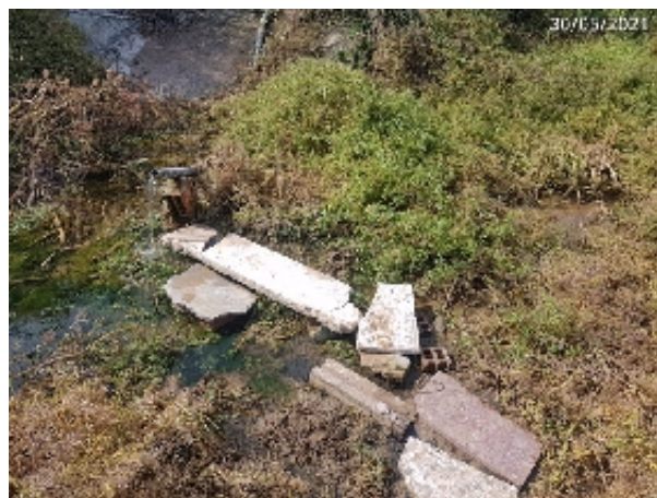
Fuente de La Cañada de Los Sastres (A. Ventas, mayo 2021)
