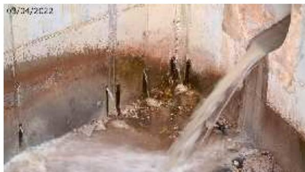
Chorros de agua por los drenajes del encofrado (A. Ventas, abril 2022)
