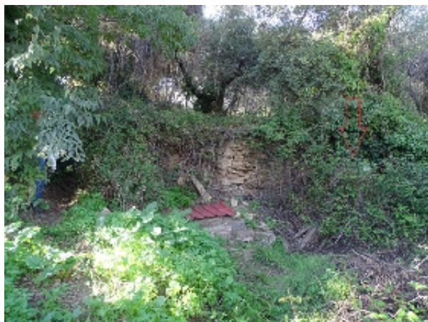
Vista general de la fuente y la alcubilla cubierta de vegetación (J. F. Martín Álvarez, noviembre 2022)
