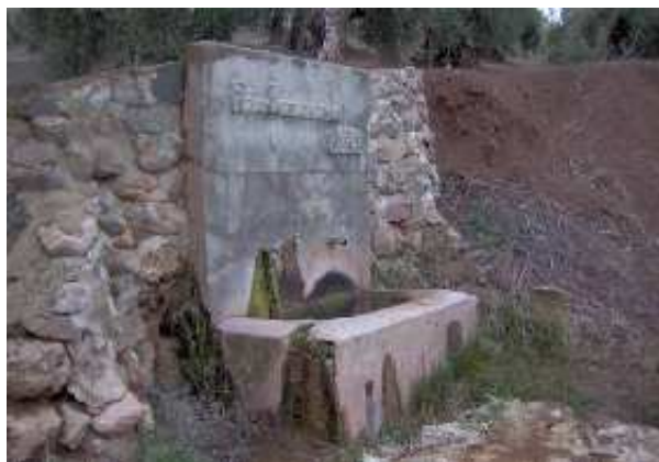
Fuente del Pozo Parragero, estado actual (D. Oya Muñoz, febrero 2009)
