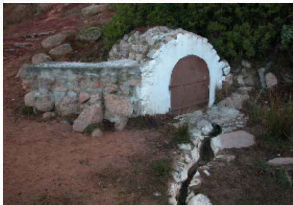
Fuente del Proveedor (R. Córdoba, diciembre 2004)
