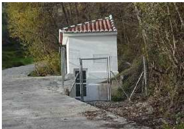
Manantial Baños, caseta de protección (F. Suarez, 2005)
