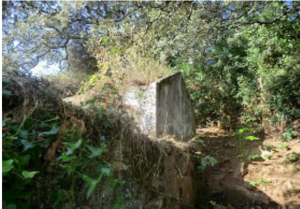
Fuente de la Cañada de la Monja, caseta (M. Trujillo, septiembre 2011)
