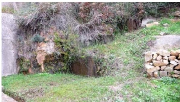
Detalle del rezume con vegetación hidrófila, El muro de hormigón drena los aportes de la fuente unidos a las filtraciones ferruginosas de la presa. (F. Sancho Royo, diciembre 2011)
