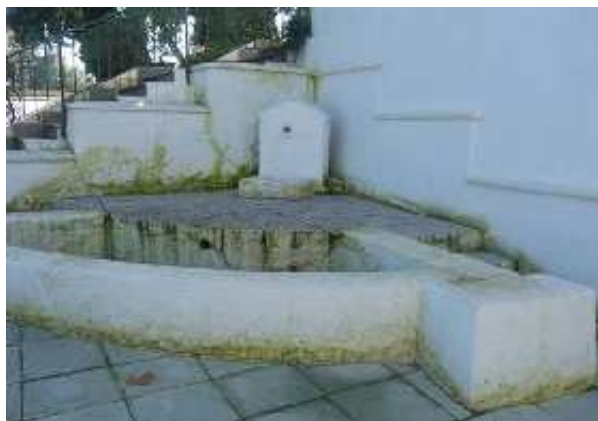
Fuente de la calle Pedro Hidalgo (L. Cano Cavanillas, enero 2013)
