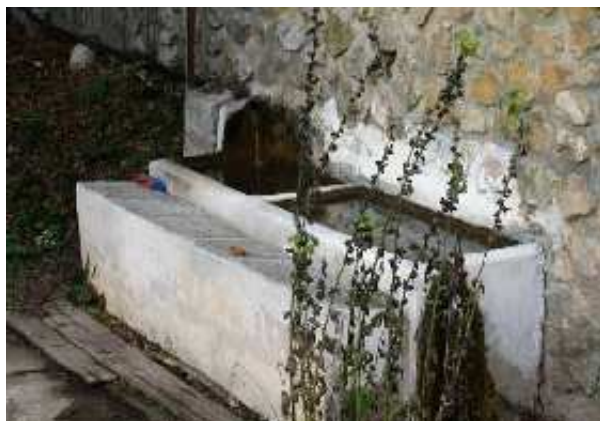
Fuente-lavadero de Tobos (L. Cano Cavanillas, mayo 2013)
