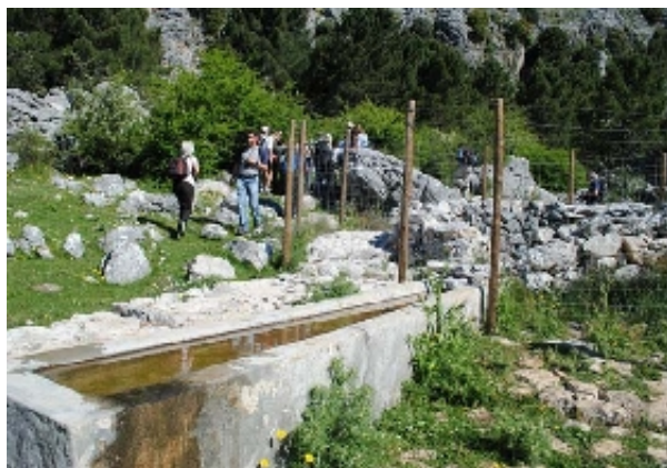
Pozo-pilar de Los Llanos del Endrinal (J. A. Palomino, mayo 2013)
