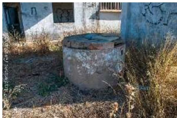
Pozo de la Antigua Estación de Jédula (J. L. Álvarez Díaz, octubre 2020)
