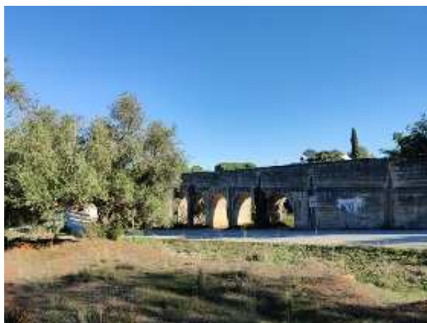
Acueducto del Canal de Riego de Bornos (M. Palomo Duarte, noviembre 2021)
