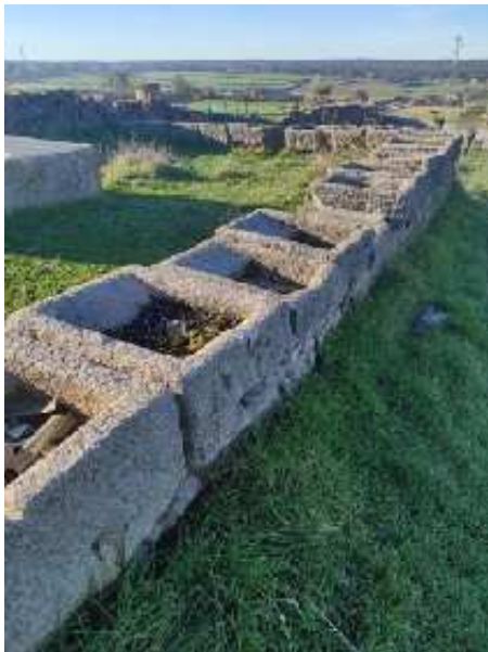
Lavadero Fuente del Caño ((es.wikiloc.com, enero 2022)
