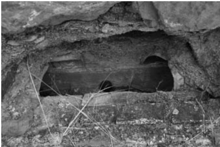
5. Canalización de barro que conducía el agua desde los acuíferos hasta las albercas. Lagar D. Cristóbal Herrera (P.R. Gálica y San Antón).
