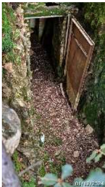
Entrada de la galería de agua o bocamina (A. Ventas, diciembre 2024)
