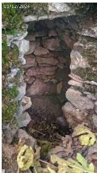
La Posita, pocillo protegido con piedra seca y entrada frontal (A. Ventas, diciembre 2024)
