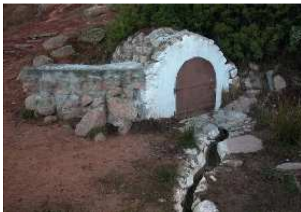
Fuente del Proveedor (R. Córdoba, diciembre 2004)
