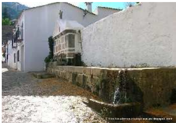
Fuente de Abajo o Fuente Romana, vista general (J.L. Valencia, noviembre 2010)
