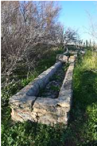
Abrevadero de los Tollos (F. J. Luengo Gutiérrez, enero 2024)
