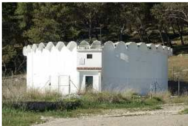
Depósito Las Canteras (M. Limón Andamoyo, marzo 2023)
